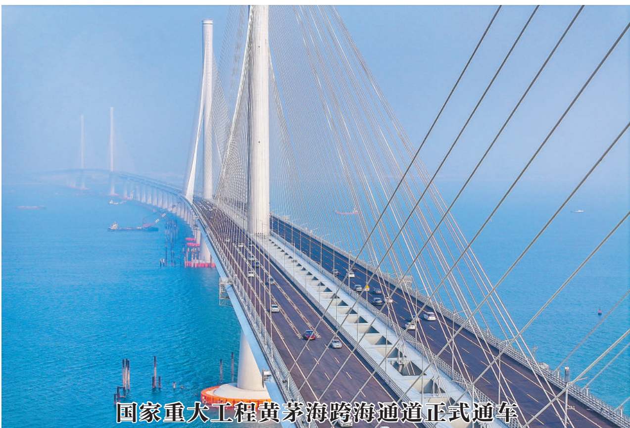
12月11日，车辆行驶在黄茅海大桥上（无人机照片）。当日，由30多家单位建设的国家重大工程黄茅海跨海通道正式通车。黄茅海跨海通道于2020年6月开工建设，是《粤港澳大湾区发展规划纲要》发布后首个开工的跨海通道工程，通道采用双向六车道高速公路标准，设计时速100公里，全长约31公里，其中跨海段长度约14公里。
