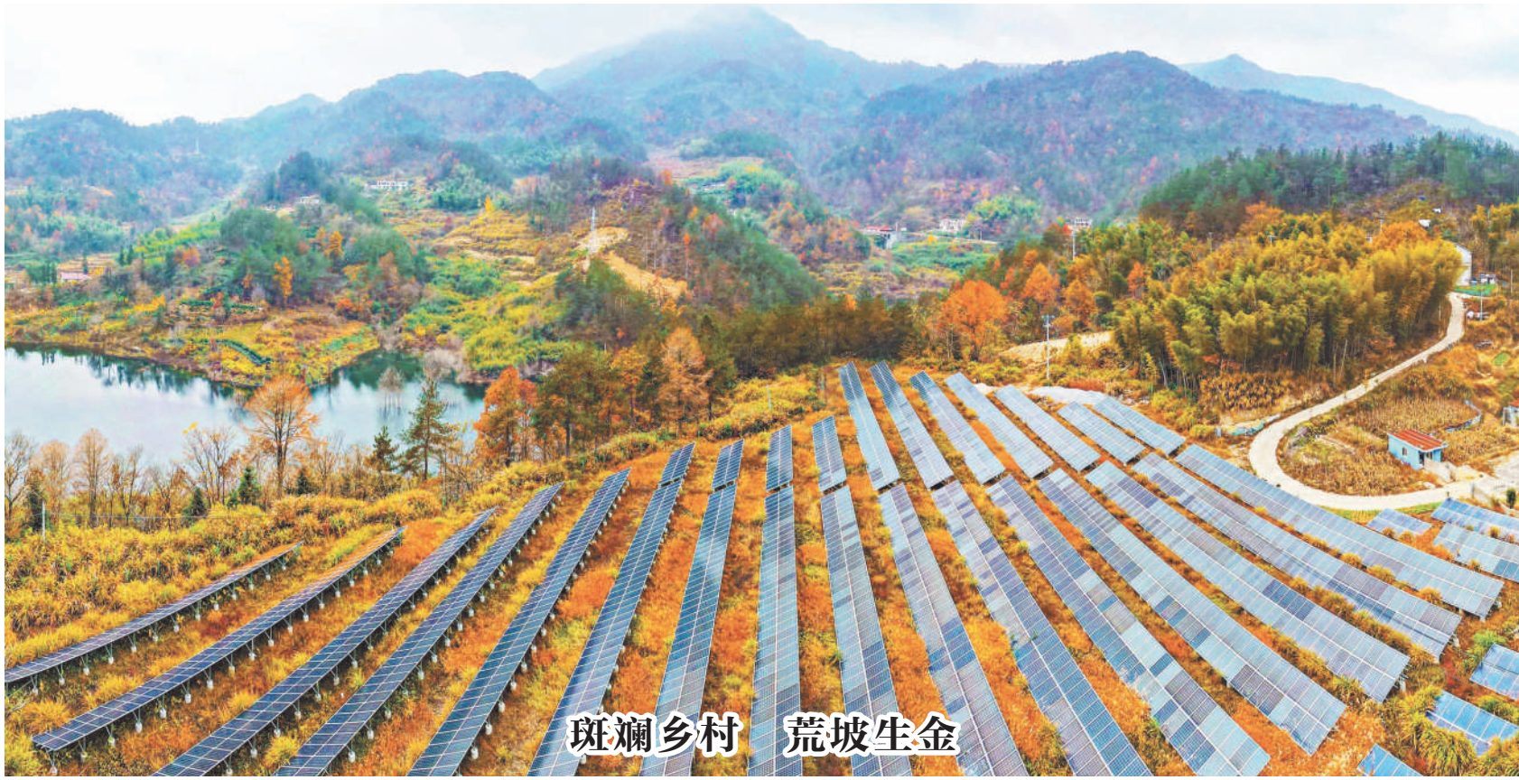
日前，在安徽省安庆市岳西县毛尖山乡精村，一排排光伏板源源不断输送着清洁能源，构成一幅美丽乡村新画卷。近年来，岳西县利用日照资源丰富优势，盘活“荒山”“摆荒地”，实施光伏“造血”工程，形成风、光、水多位一体的清洁能源发展新格局。 吴均奇 摄
