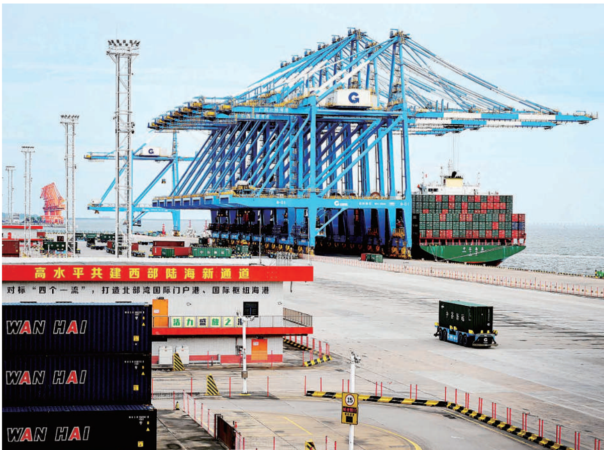
北部湾港钦州自动化集装箱码头是全国首个海铁联运集装箱码头，也是全球首个成功使用“U”型工艺方案的码头。近年来，广西以高水平共建西部陆海新通道为牵引，加快打造向海经济，推动构建陆海相通、多区联动的开放格局。图为6月16日，钦州自动化集装箱码头作业一角。
