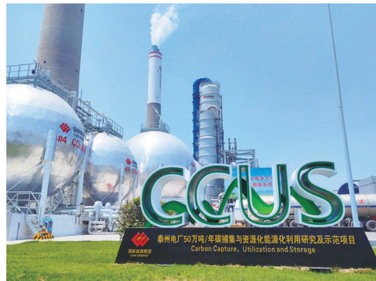
亚洲最大的燃煤电厂燃烧后碳捕集工程——江苏泰州电厂50万吨/年CCUS示范工程，该工程完全由我国自主设计、制造、安装。
