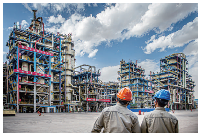
宁夏煤业400万吨/年煤间接液化示范项目厂区
