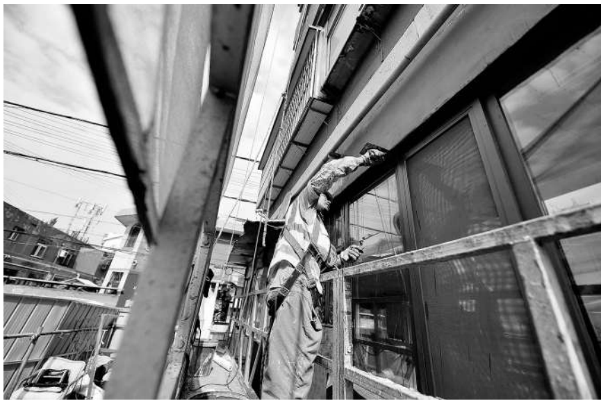
8月3日,银川市兴庆区游乐小区,施工人员进行楼体外立面保温墙改造。 范文杰 摄
