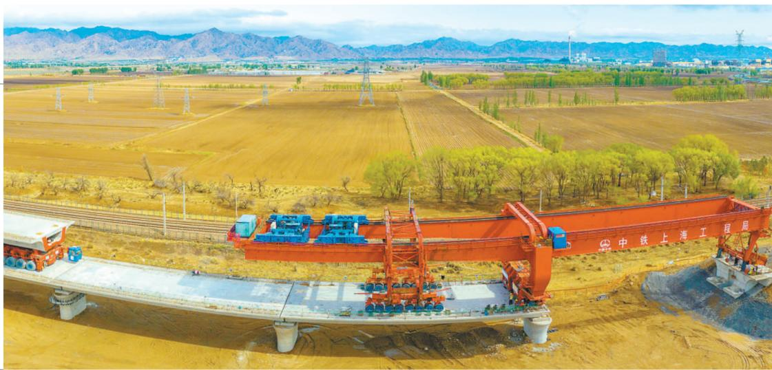
5月5日拍摄的包银高铁跨万甘铁路特大桥箱梁架设施工现场(无人机照片)。
