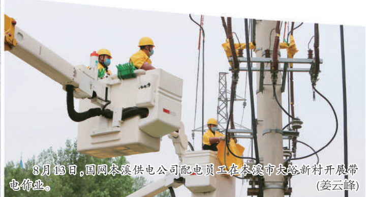
9月2日,国网本溪供电公司员工在辽宁省本溪县小市镇林村10千伏山关线80~86号杆上进行线路换线作业。(姜云峰)
