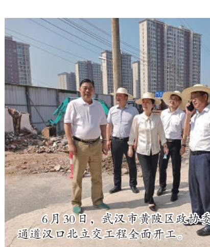
6月30日,武汉市黄陂区政协委员现场协商推进岱山通道汉口立交工程全面开工。
