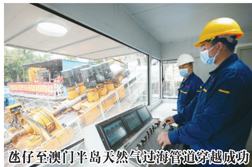
近日，氹仔至澳门半岛天然气过海管道穿越成功。图为3月28日拍摄的过海管道入土点。 新华社发
