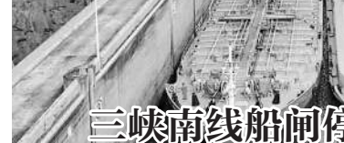
三峡南线船闸停航检修圆满完成
