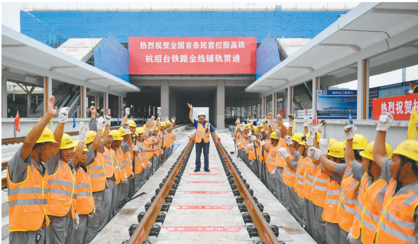
6月22日，中铁十一局的施工人员在杭绍台铁路温岭站施工现场庆祝铺轨贯通。当日，我国首条民营控股高铁杭绍台铁路全线铺轨贯通。2017年9月11日，由复星集团牵头的民营联合体与浙江省政府正式签署“杭绍台铁路PPP项目”投资合同，这也是中国首条民营控股高铁项目。复星集团牵头的民营联合体占股为51%。 新华社
