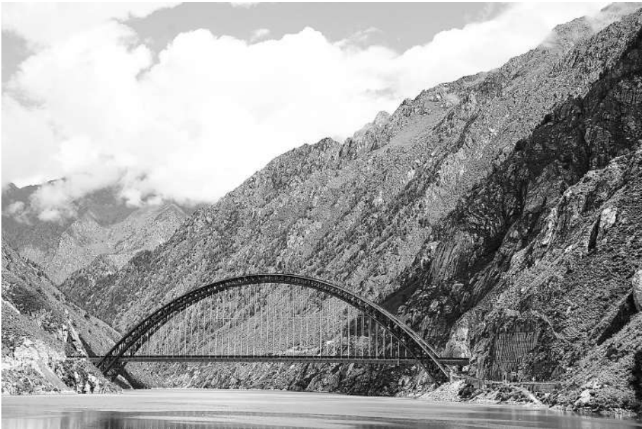
藏木雅鲁藏布江双线特大桥全长525.1米，主拱跨径430米（2021年7月11日报）。
