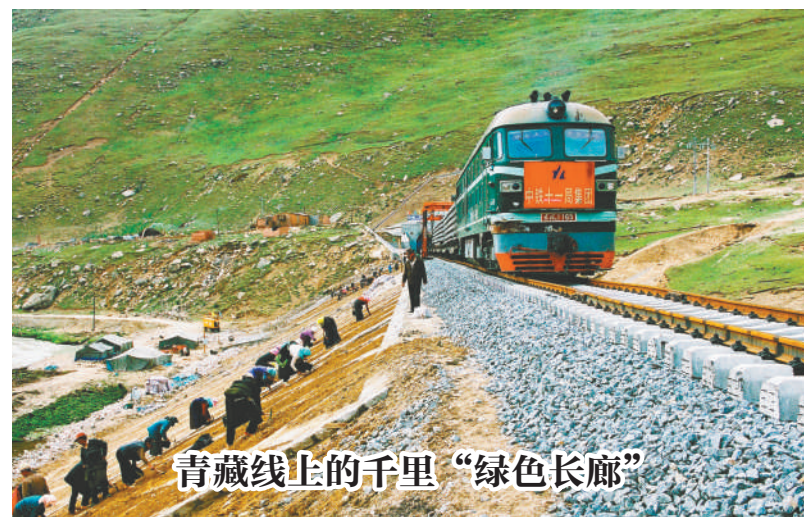
青藏铁路运行15年来,铁路部门采取“宜乔则乔、宜灌则灌、宜草则草”的方法,实施“绿色天路”工程建设,在4600米至4900米的高海拔冻土区段,采取铺设保温塑料膜覆盖、植生袋等方式,种草189.9公里、557.5公顷,形成了一道千里“绿色长廊”。 干章林 摄
