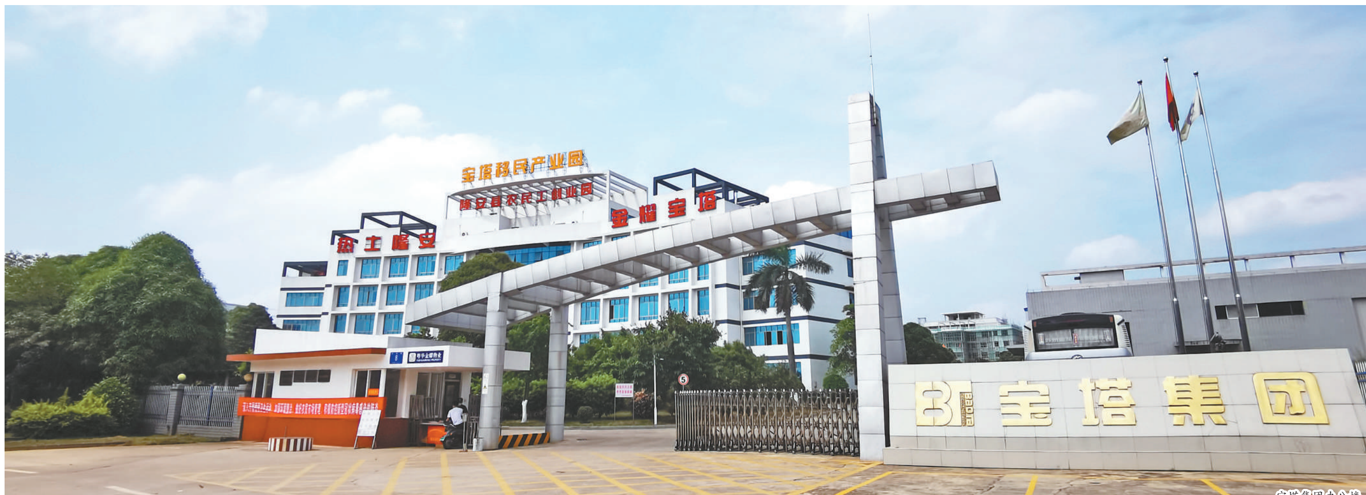
宝塔集团办公楼
